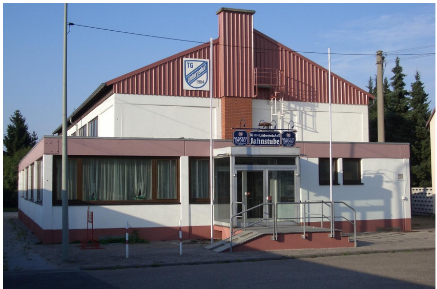
Abbildung 15: Die Jahn-Turnhalle mit neuem Dach (Aufnahme 2004)
